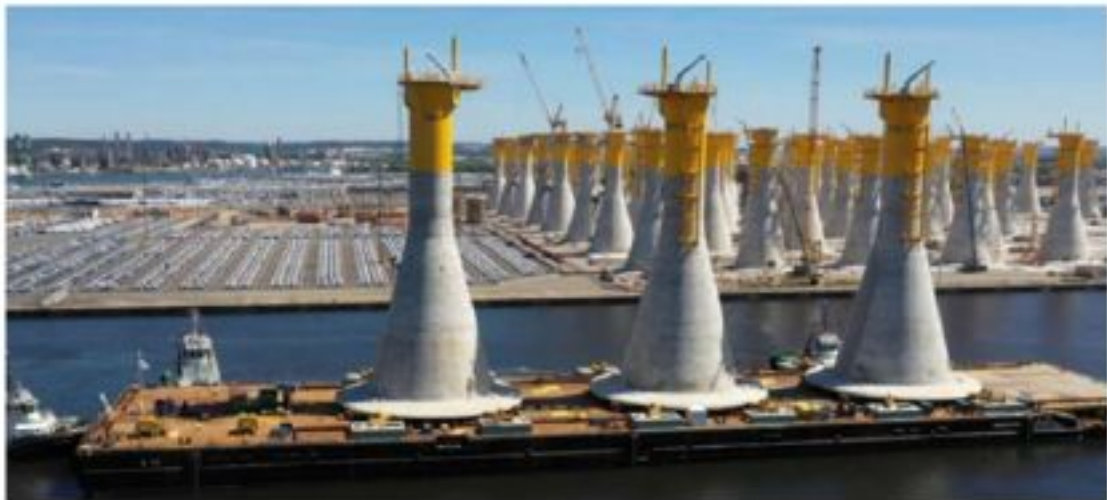
Figure 24 : Photos de l'export des fondations gravitaires en béton pour le parc éolien en mer de Fécamp, situé dans le port du havre (2020 – 2022 ; source : Bouygues TP).
